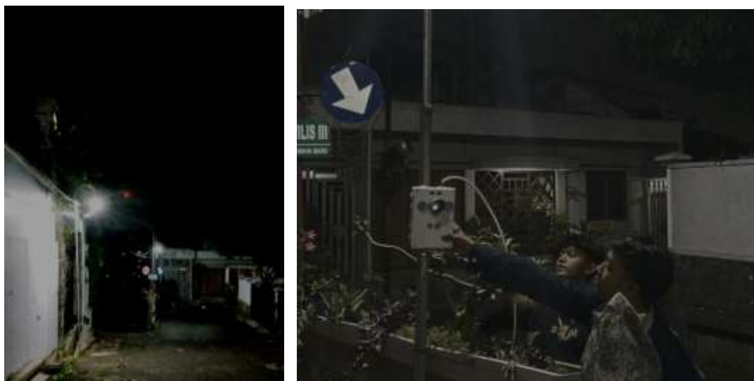
Gambar 2. Implementasi IoT Smart-Alarm System untuk jalan curam
